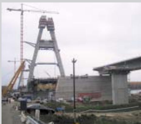
4 MO Északi Duna-híd
